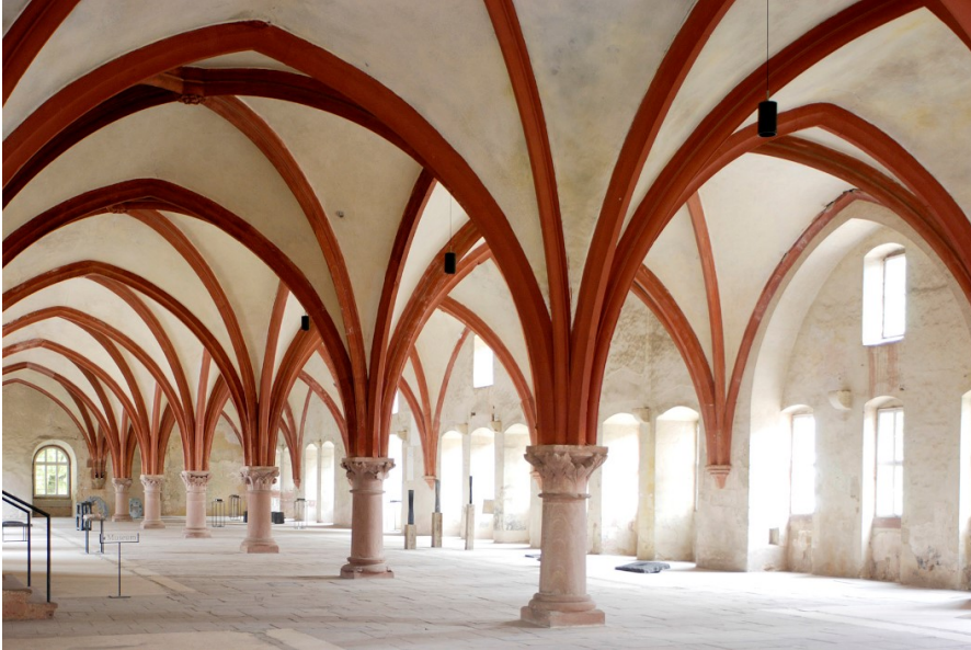
Mönchsdormitorium © Stiftung Kloster Eberbach
